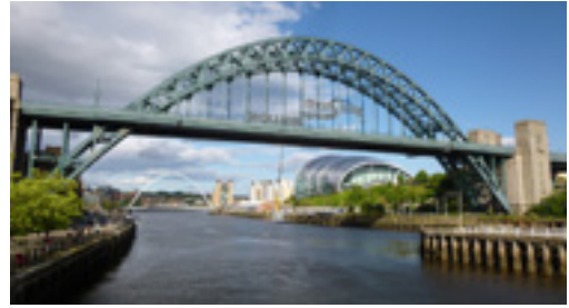
Newcastle: Brücken über den Tyne
